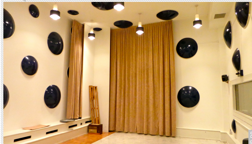
Chambre claire , très sonore, de 6m sur 8m, et 5 m de hauteur. « Sa longueur de réflexion varie en jouant avec les grands rideaux de velours. Cette pièce est utilisée pour avoir les couleurs d'église ou de cathédrale. »
